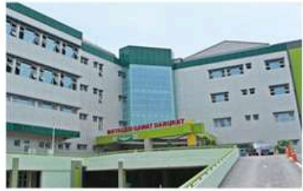
Indonesia, RSUD H. Mursid Indramayu
